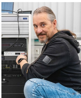
Bester Anschluss: Haustechniker Werner Menzl bei der Arbeit
